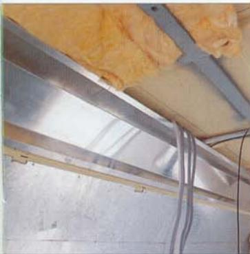
Wände und Decken sind hinter den Verkleidungen verstärkt und kälte-, wärme- und schallisoliert. Die Verkabelung wird in Leerrohren verlegt, um sie vor möglichen Beschädigungen zu schützen ■
