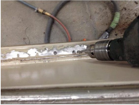
Ausbohren der alten Schweißpunkte
