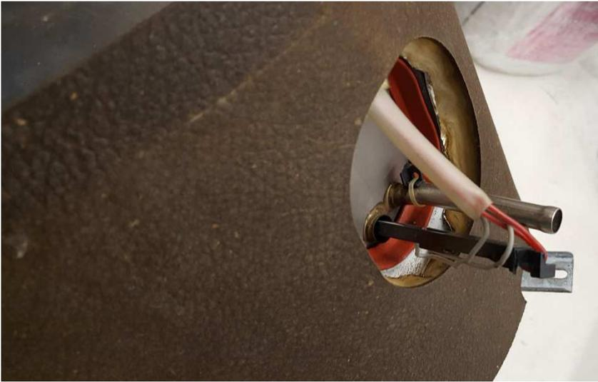
Temperaturfühler rausziehen und beim Rausnehmen des Kessels auf rote Dichtung achten.
